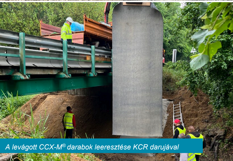
CCX-M® függőleges irányú terítéke vízfolyásnak megfelelő átlapolással
