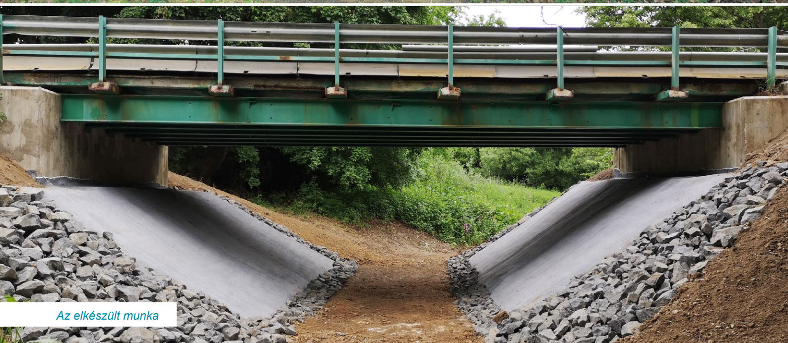
A rézsűk a kivitelezés előtt
