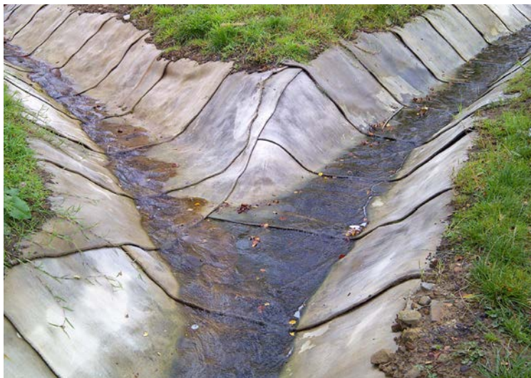
A CC-vel könnyen kialakíthatóak összevezetések és lezárások
