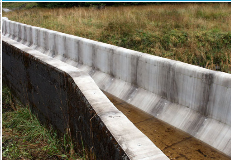
A CC szintén alkalmas meglévő beton csatornák burkolására
