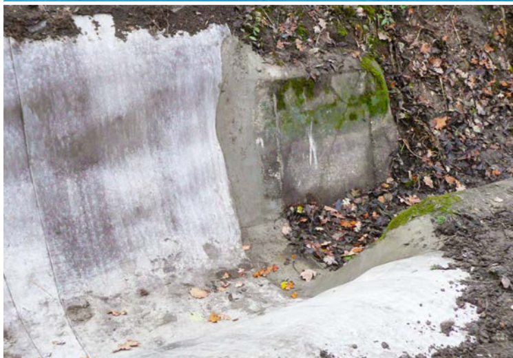
Megfelelő habarccsal a CC meglévő infrastruktúrához illeszthető
