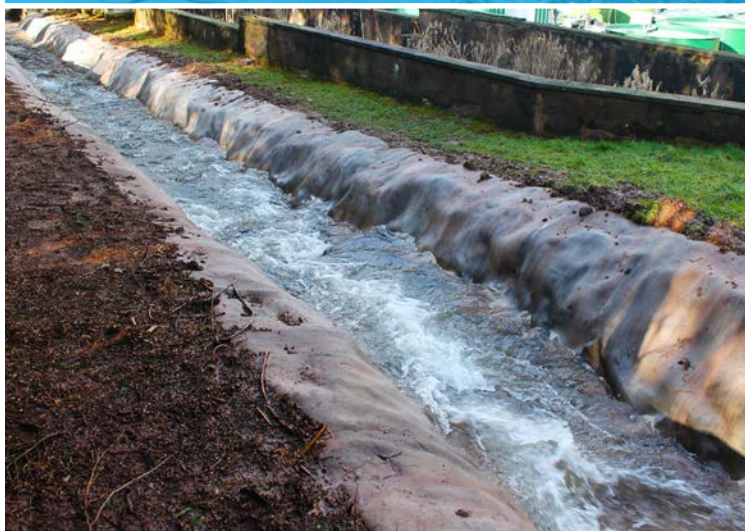
A CC jól illeszkedik és követi az árok vagy rézsű felszínét körvonalát
