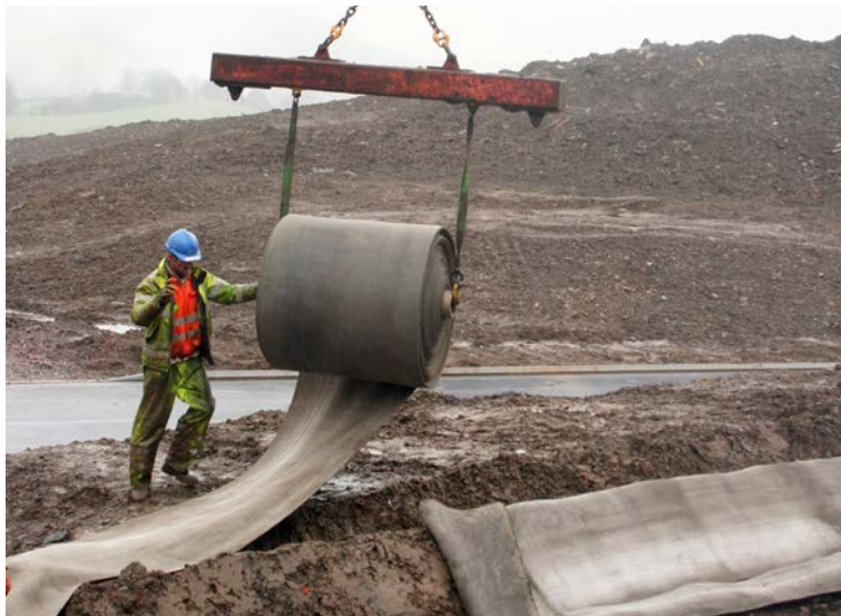
Letekercselő szerkezettel terített nagytekercs
