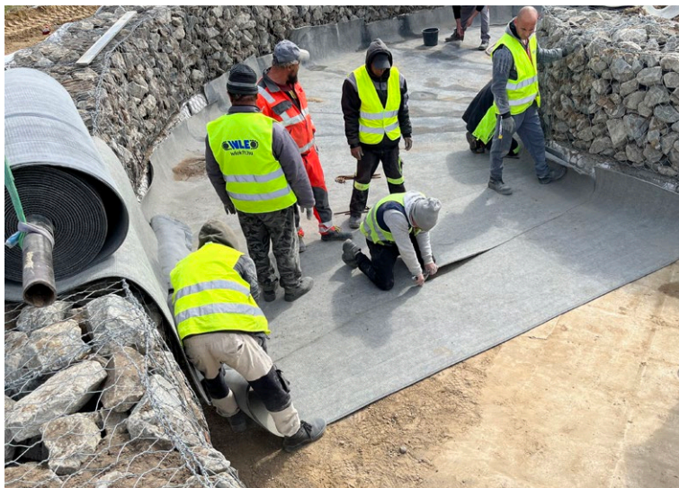
Anyagfelhasználás optimalizálásához tortaszélet (trapéz) alakú darab kivágása
