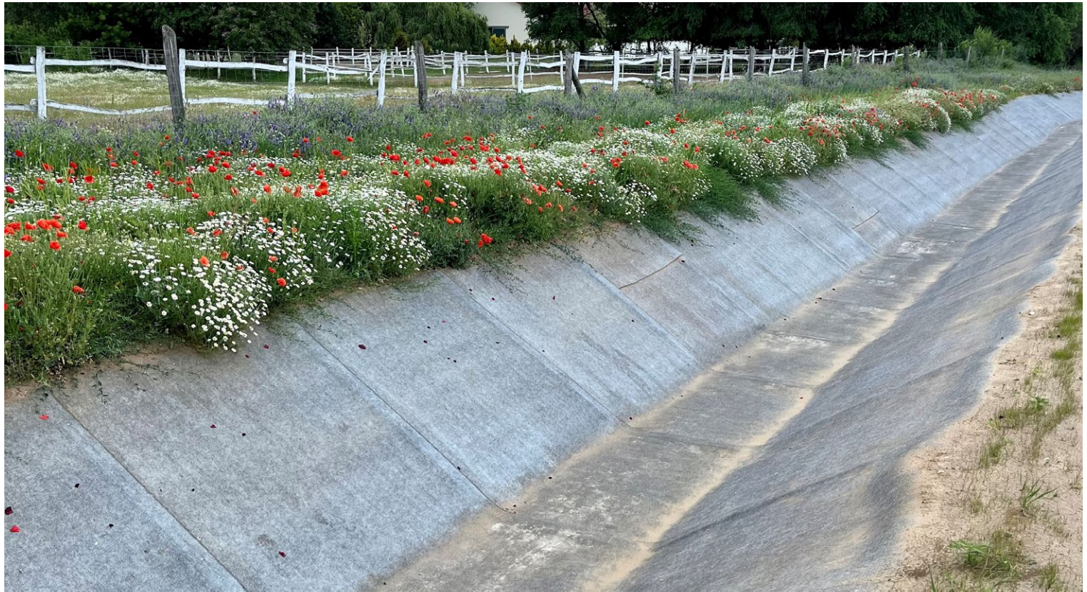
6 hónappal a kivitelezés után
