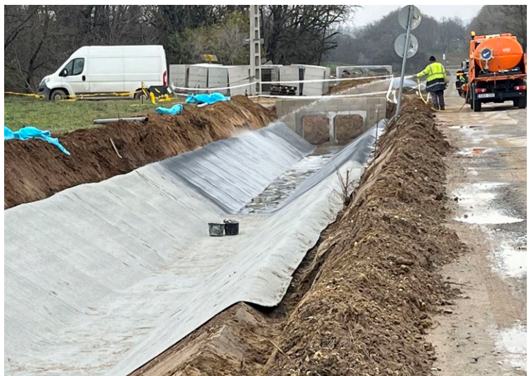
CCX-M™ hidratálása locsolóautóból locsolócsővel
