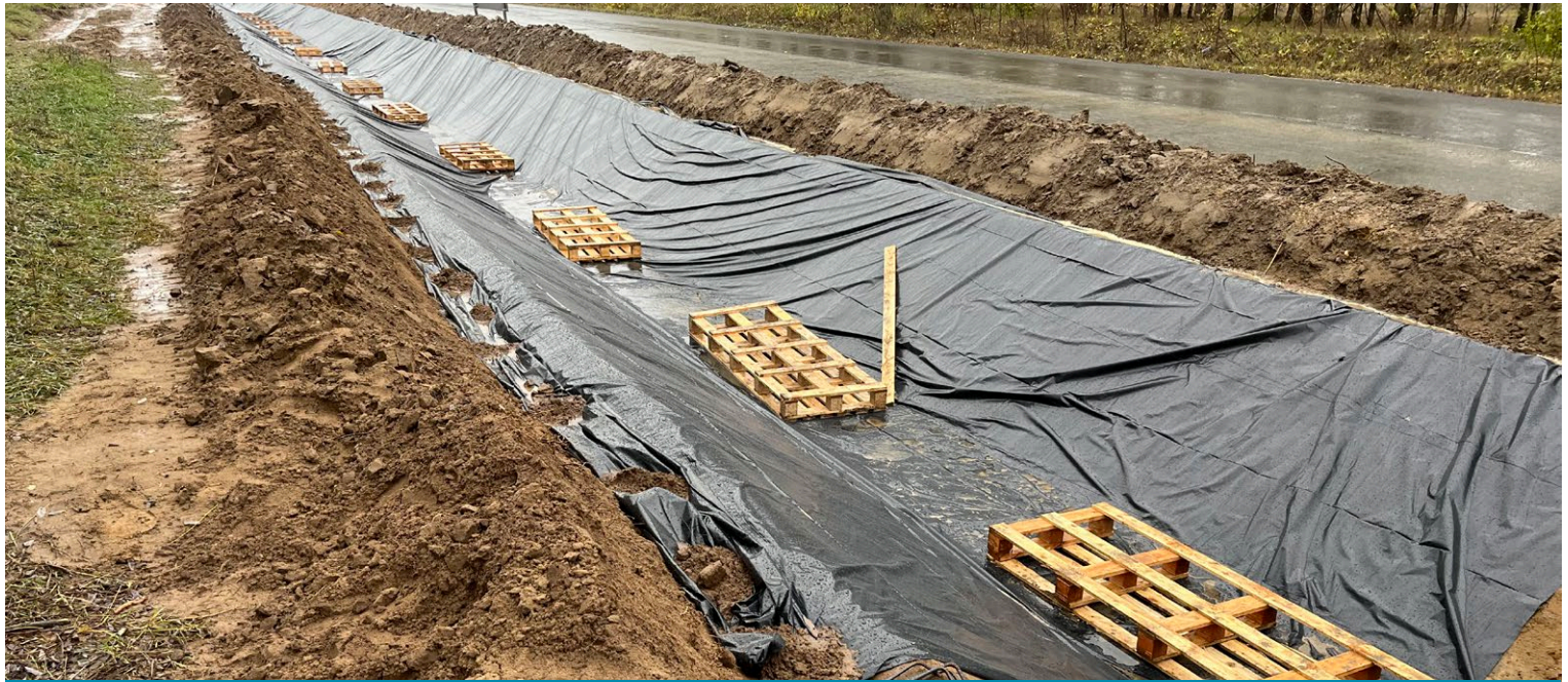
Az optimális kötés érdekében az alacsony hőmérséklet miatt föléval takart, hidratált CCX-M™
