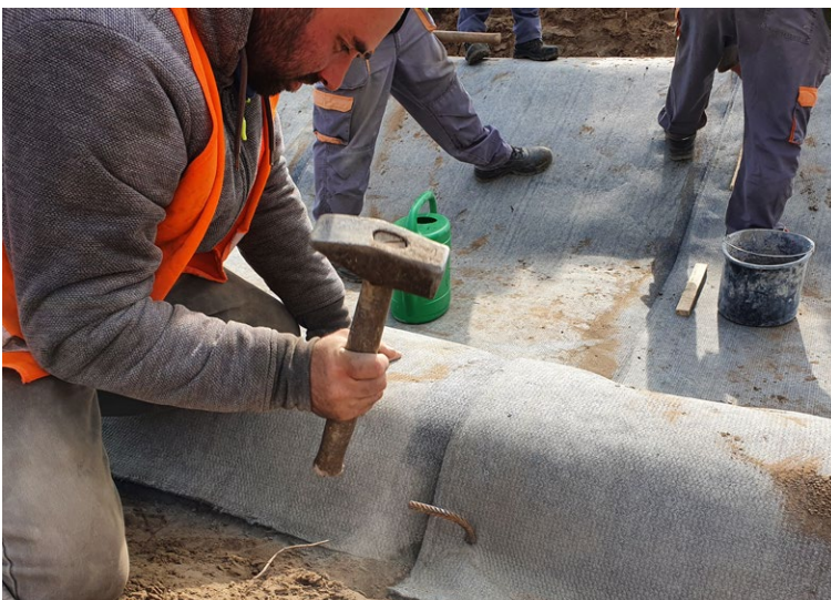
A szélek rögzítése cövekkel a leterhelő árokban
