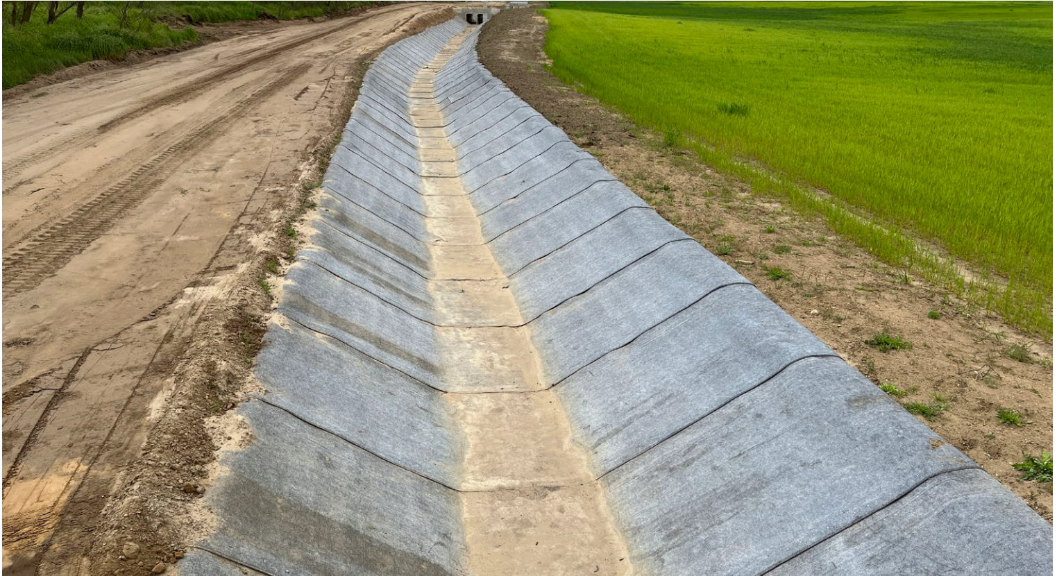
Egy megépített csatornaszakasz
