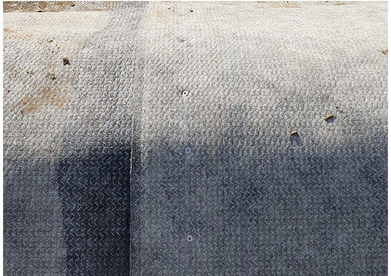
Az átlapoló CCX-M™ rétegek kötése 100 mm-ként csavarozással
