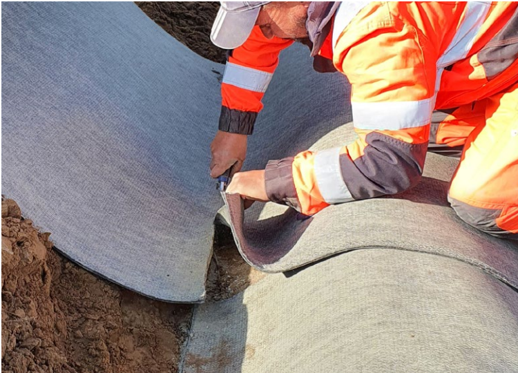
CCX-M™ méretre vágása kézi vágóeszközökkel
